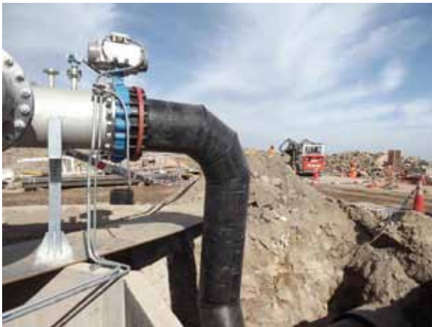
Válvulas / Flanges / Codos \phi 500 mm. PN-10
